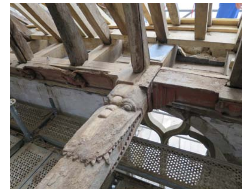
Restauration de la charpente sculptée du transept
