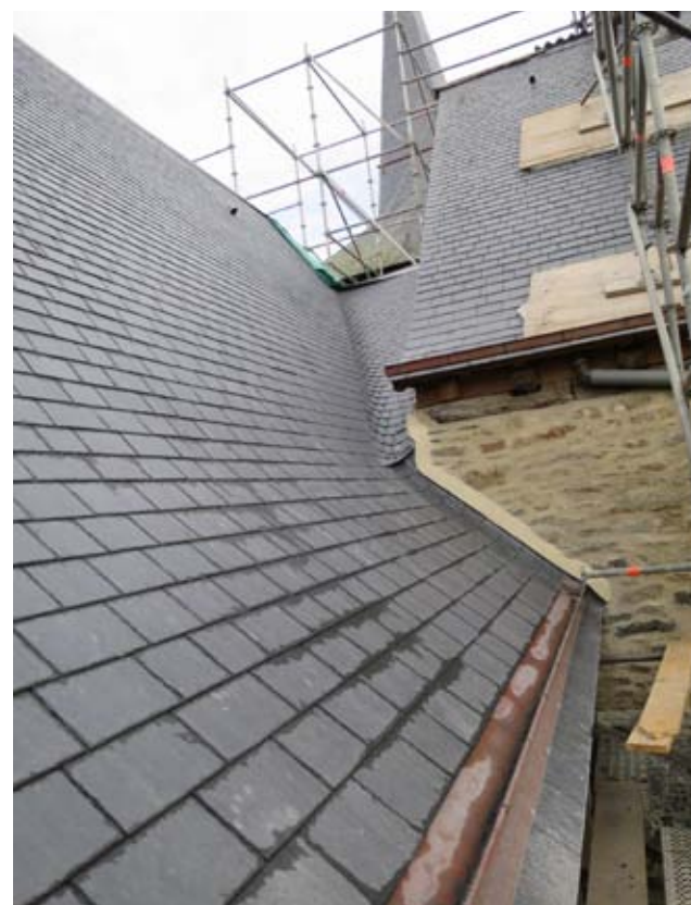
Pose de la couverture neuve du transept
