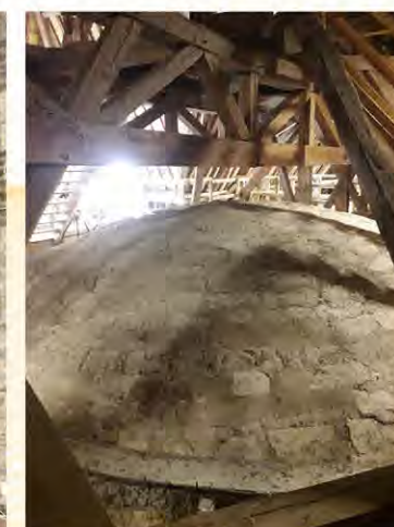
Charpente de l'église Saint-Yves - Vannes
